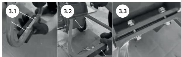
4. Установите разгрузочный ёлоб через прокладку и закрепите его четырьмя болтами.
